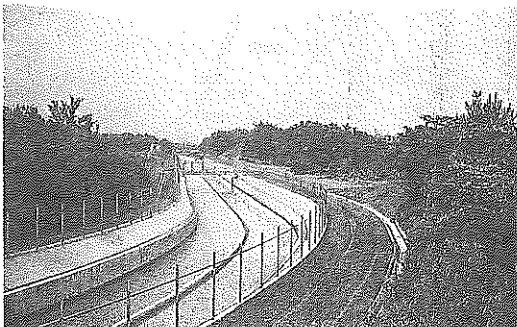
愛知用水の水路 (木曾川の水を知多半島へ導く農工業用水、幹線水路110km, 1961年完成)
