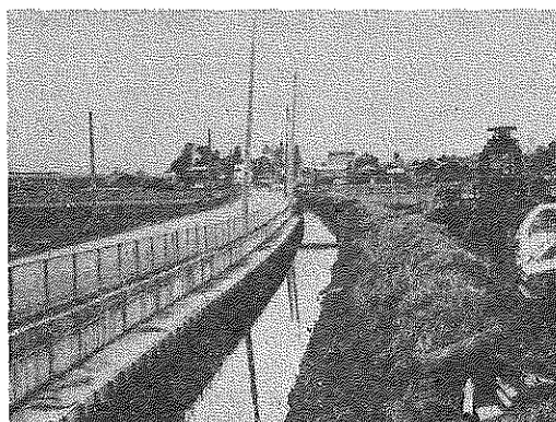
写真3-a 十六輪中排水路
