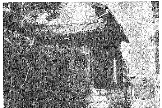
写真1-a 十六輪中G家水屋（側面）
